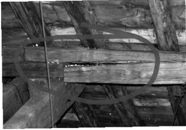
Architekt und Statiker zeichnen ein klares Bild vom Dachstuhl der Pfarrkirche, ihre Fotos lassen das Ausmaß der Schäden erahnen. Der Dachstuhl ist überlastet, die daran hängende Rabitzdecke aus Gips und Stahl ist zu schwer. Balken sind schon gebrochen und wenn weitere Balken nachgeben, droht die Decke einzustürzen.
